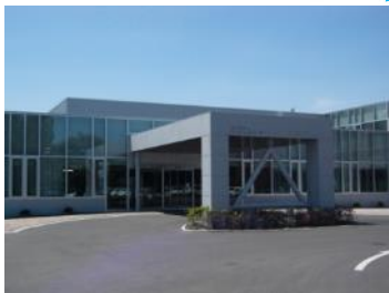
1号館正面玄関 (平成19年2月改修)
